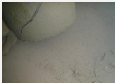
Figur 5: Støv som har lagt seg i stamp hos RF etter noen måneder
